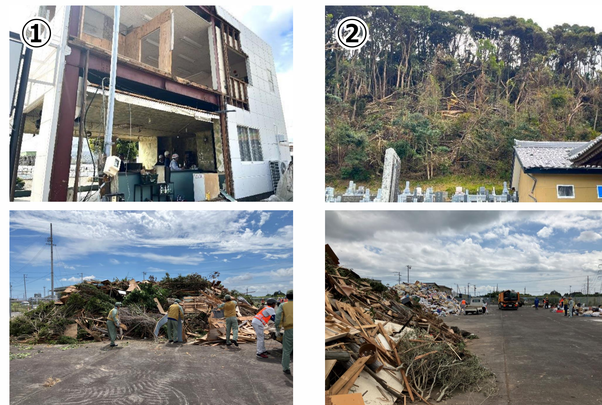
牧之原竜巻による被害状況の例
