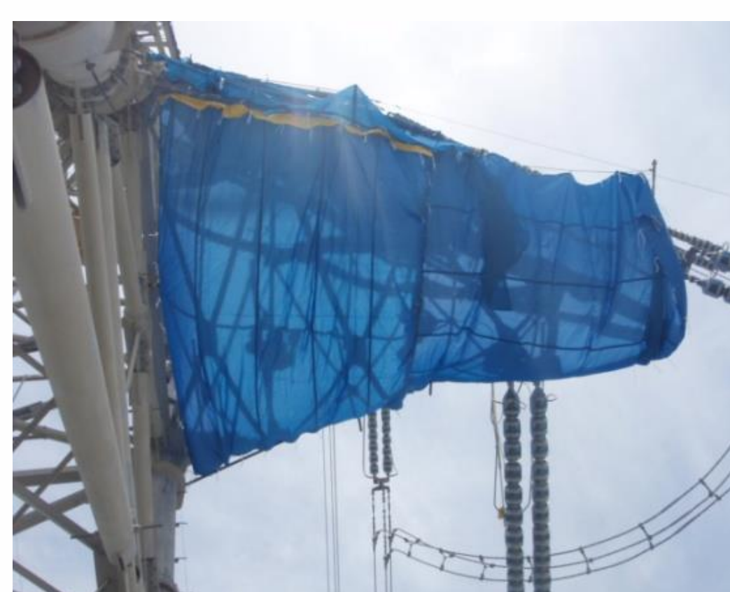
鉄塔塗装時の施工例（下から撮影）
